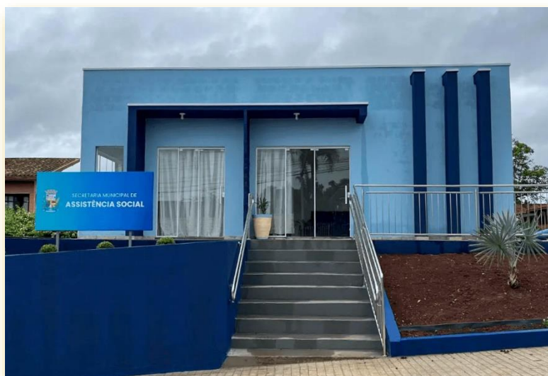
Figura 20- Fachada da Secretaria Municipal de Assistência Social de Guamiranga
